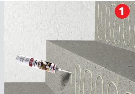
Montagekleber auf die Setzstufe auftragen und den zugeschnittenen Bodenbelag anbringen.
