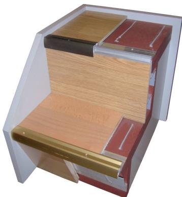
Mit Hilfe der Mustertreppen kann der genauere Aufbau erläutert werden. Die Produkte werden anschaulicher präsentiert.
