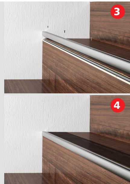
**TOP-Profil zuschneiden, dabei auf die passgenaue Ausrichtung der längeren Schenkel vom TOP-Profil zur Verschiebenut des BASIS-Profils achten. TOP-Profil verschrauben. Fertig ist die sichere Stufenkante.**
